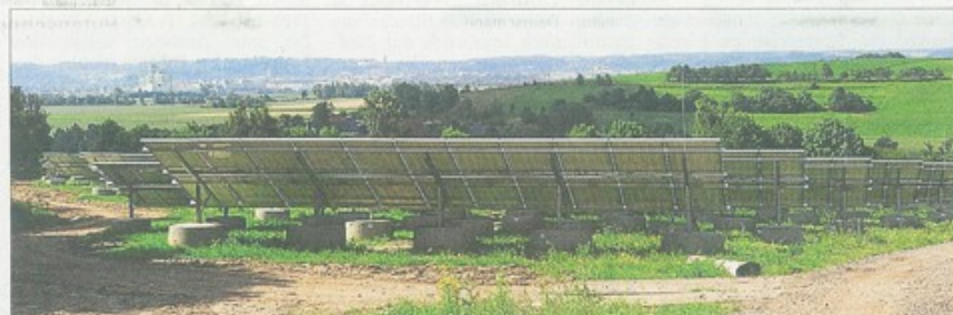
Die Kehrseite der Energiewende: Die Photovoltaikanlage auf der Reststoffdeponie Spitzberg konnte bislang noch nicht ans Netz gehen, da Eon mit der Ausführung der eingegangenen Anschlussanträge geraume Zeit in Verzug ist. (Foto: gt)
